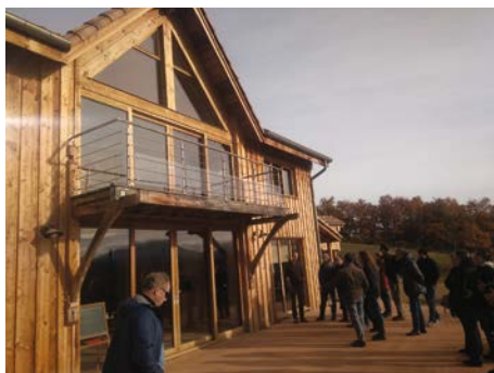
Visite d'une maison poteau-poutres à Campagne sur Aude
