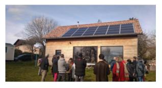
Orientation plein sud, pièces « tampon » au nord, faibles ouvertures au nord et à l'ouest, grandes baies vitrées au sud et mur Trombe en briques de terre crue.
