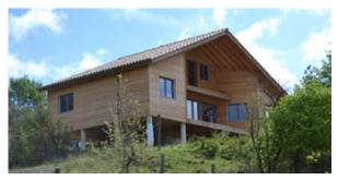
La conception a été guidée par une recherche d'autonomie en eau et en chauffage : forte isolation, conception bioclimatique, orientation sud, insert bûches.
