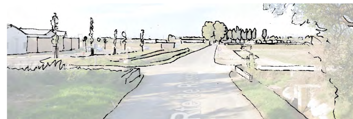
Entrée de village depuis Raissac
