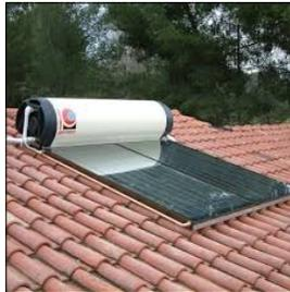
**Le CESI à éléments séparés :** Un liquide caloporteur circule entre les panneaux et le ballon et est chauffé sous l'effet du soleil et transmet la chaleur à l'eau du ballon par l'intermédiaire d'un serpentin placé en partie basse du ballon.
