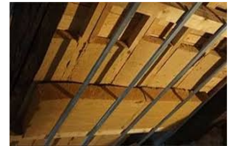
Isolation sous rampants
