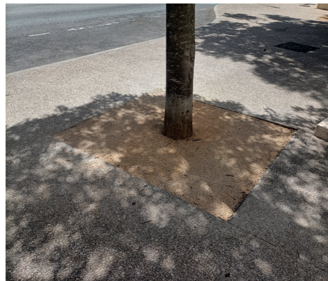
Exemple de désimperméabilisation de pied d'arbre - sans plantations ni bordures pour conserver une largeur suffisante d'au moins 1m40 pour les circulations sur le trottoir.
