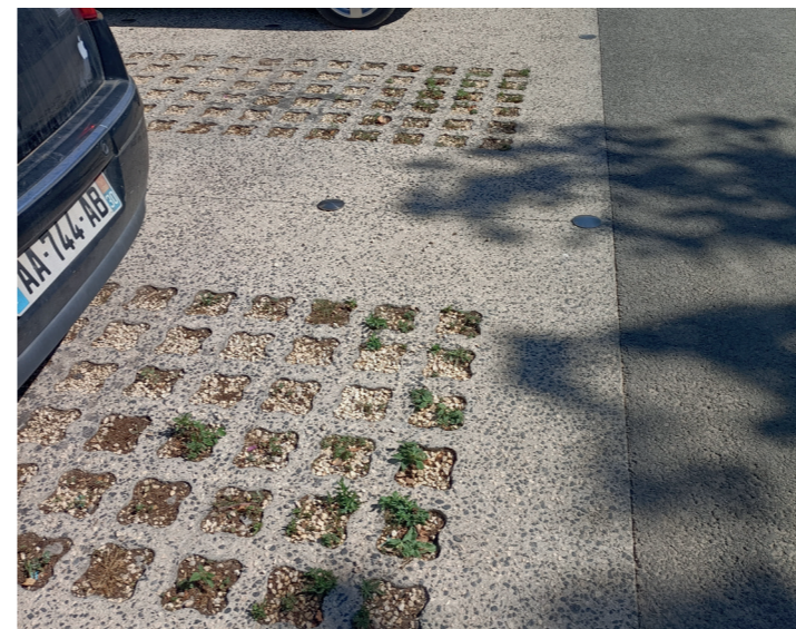
Désimperméabilisation partielle de places de stationnement en centre urbain.
