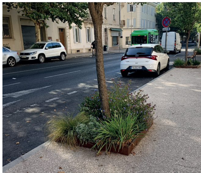
Exemple de désimperméabilisation de pied d'arbre - plantation de vivaces et bordures en acier corten permettant d'avoir une épaisseur de terre plus importante et de protéger les plantations.
