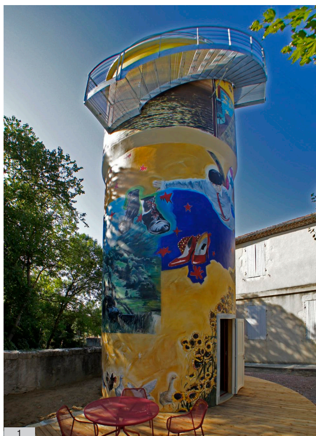
1. Vue d'ensemble du château d'eau
