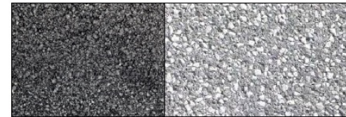
1_Enrobé voirie et trottoir route de Sonnac
