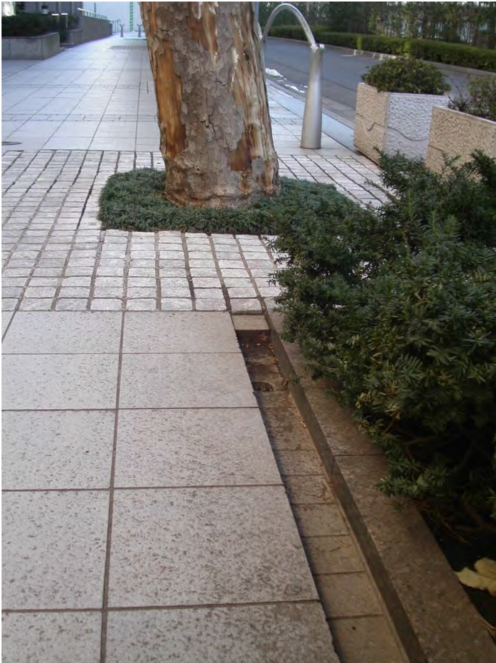
TOKYO – DISPOSITIF DE RÉCUPÉRATION DES EAUX PLUVIALES
