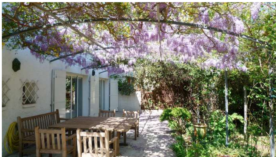
Une pergola, support d'une végétation aux feuilles caduques, protège la façade de la surchauffe due au rayonnement solaire direct, l'été, tout en lui permettant d'en bénéficier, l'hiver.
