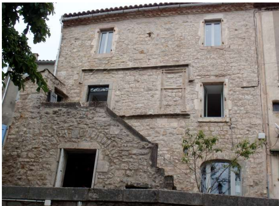
Cette façade porte de nombreux témoignages de son histoire. Dommage qu'elle ait été dénudée de ses enduits et munie de menuiseries banalisantes
