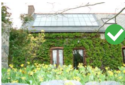
Le rapport nuancé entre les couleurs des ardoises et des panneaux solaires fait que la toiture du bâtiment dans sa perception globale, proche ou lointaine, présente une certaine homogénéité.
